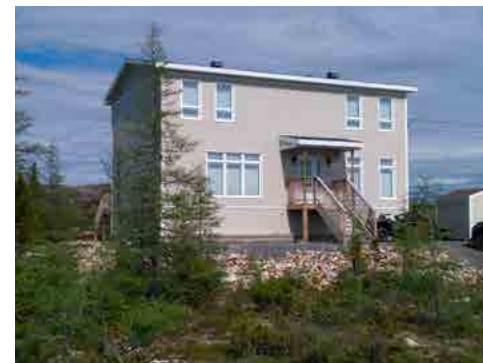
Source : Office municipal d'habitation Kativik
